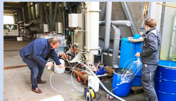
Versuche mit Pilotwäscher, Aktivkohle und Duftstoffzuführung
