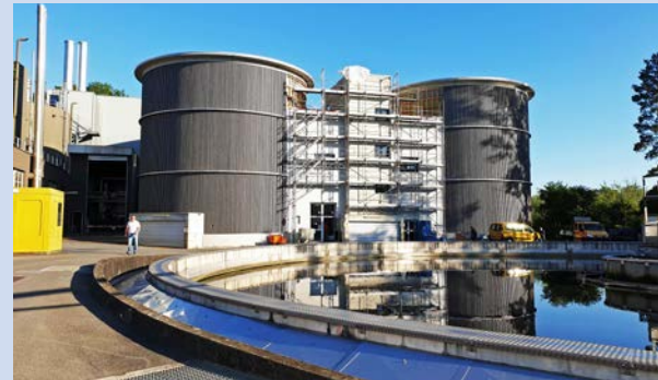
Aufstockung Mitteltrakt der Stapelanlage
