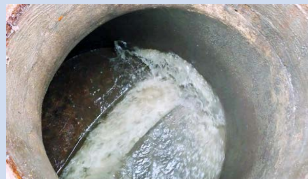
Mangelhafte Schachthydraulik
