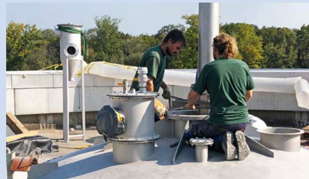
Stapelanlage: Rührwerkmontage auf der neuen Gashaube
