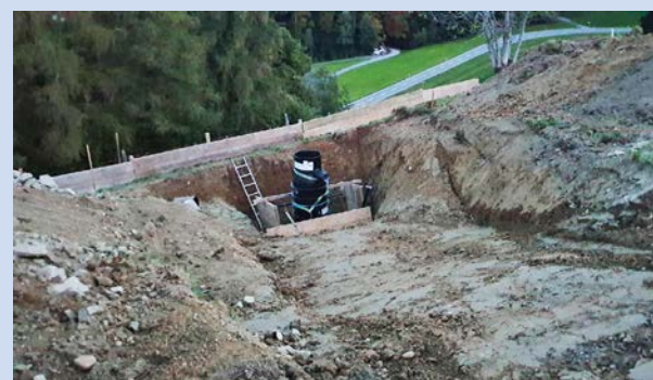
Entgasungsgefäss DÜ Steingrueben
