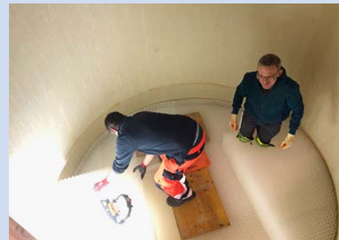
Austausch der alten Füllkörper im Gegenstromwäscher – Bild links: alte Füllkörper, Bild rechts: strukturierte Packung
