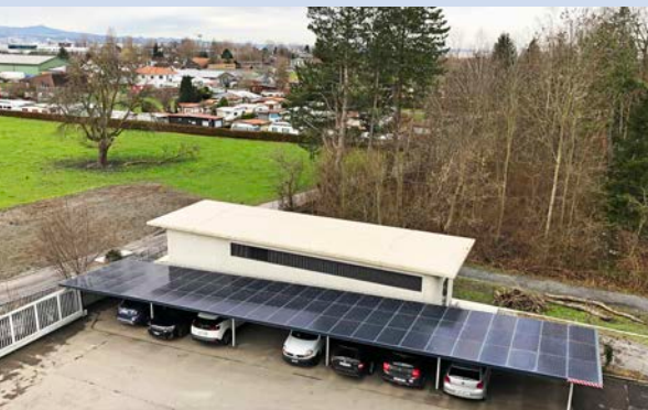
Die Anlage verfügt über eine Leistung von 22 kWp.
