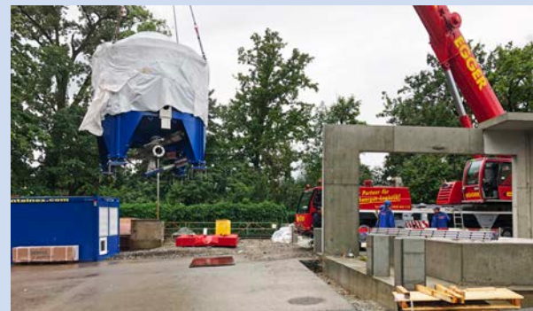
Einbringung der Anlagentechnik; im Bild das Herzstück «Pulper»
