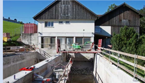
Umbau ARA Trogen
