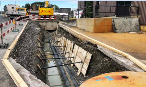
Erdverlegung der internen Gasleitung
