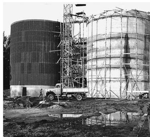
Unterlagsbeton mit V-Graben für die Entwässerungsleitungen, untere zylindrische Wände des Faulturms 4, Wickelmaschine für die Vorspanndrähte um den Betonsilo. Dank dem vorgespannten Draht-Korsett konnten die Wände dünner und stabiler gestaltet werden. Die Vorspanndrähte wurden mit einem Gunit-Überzug geschützt. Isolationsmatten dienten der Reduktion des Wärmeverlusts in den geheizten Faulräumen, darüber eine Eternitverkleidung.
