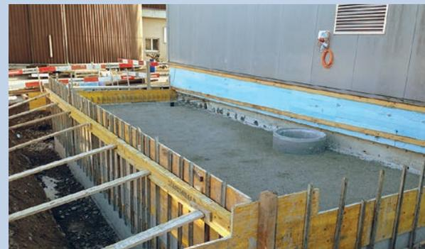
Bau des Fundaments für den Presscontainer
