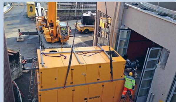
Einbringung des BHKW in die Maschinenhalle
