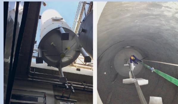
Einbringung der Behälter in das Gebäude und Entfernung der Rührwerks-Transportsicherungen
