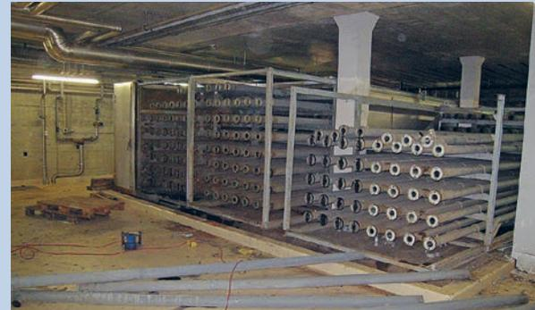
Rückbau des Schlammwärmetauschers
