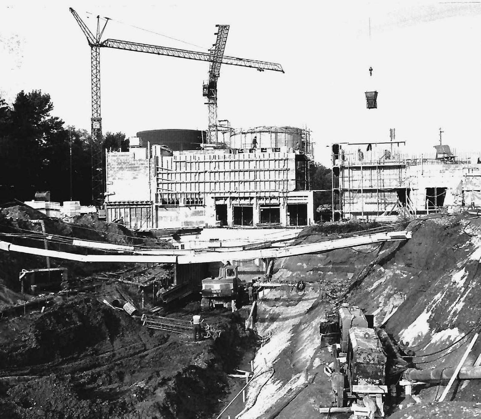
V-Grabenaushub für den Einbau des letzten Hauptkanalteilstücks und des Kiesfangs mit Anschluss an das Hauptpumpwerk. Im Hintergrund das sich im Aufbau befindliche Betriebsgebäude, in dessen Kellergeschoss das Hauptpumpwerk zu liegen kommt.
