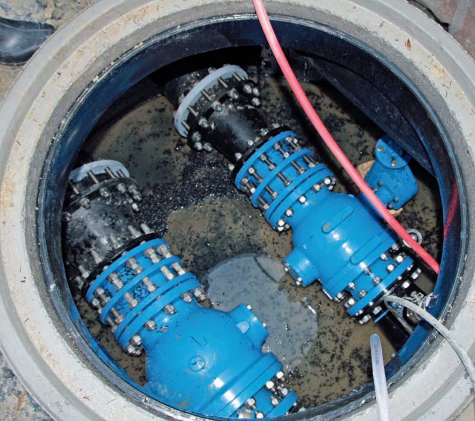
Interventionsschacht mit Absperrschiebern; während der Druckprüfung mit 20bar
