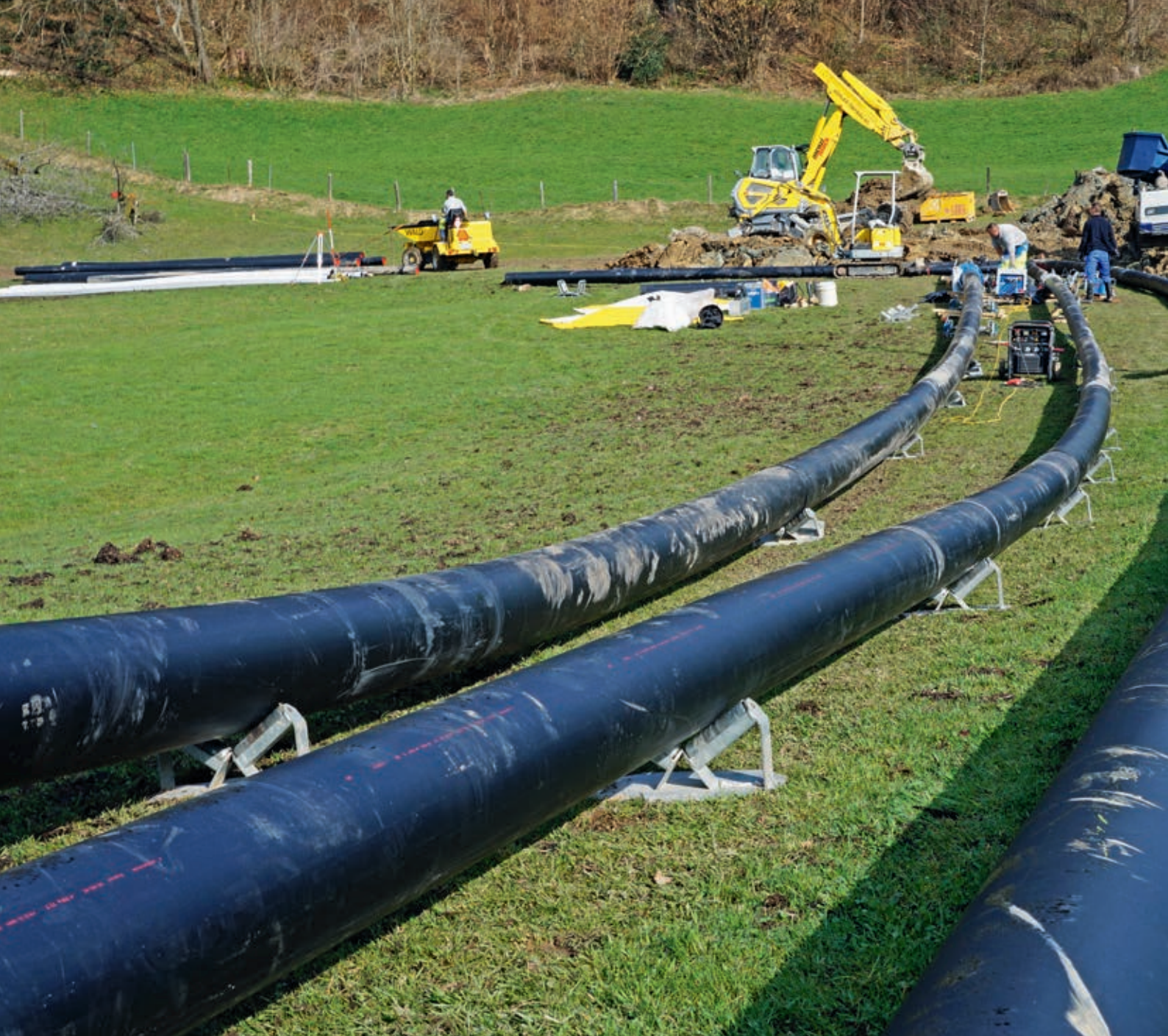
Konventioneller Graben- und Rohrleitungsbau im Gebiet Risel, Eggersriet
