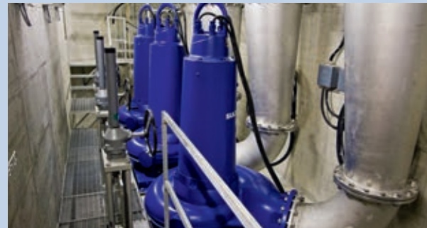
Neue Pumpen für Notentlastung
