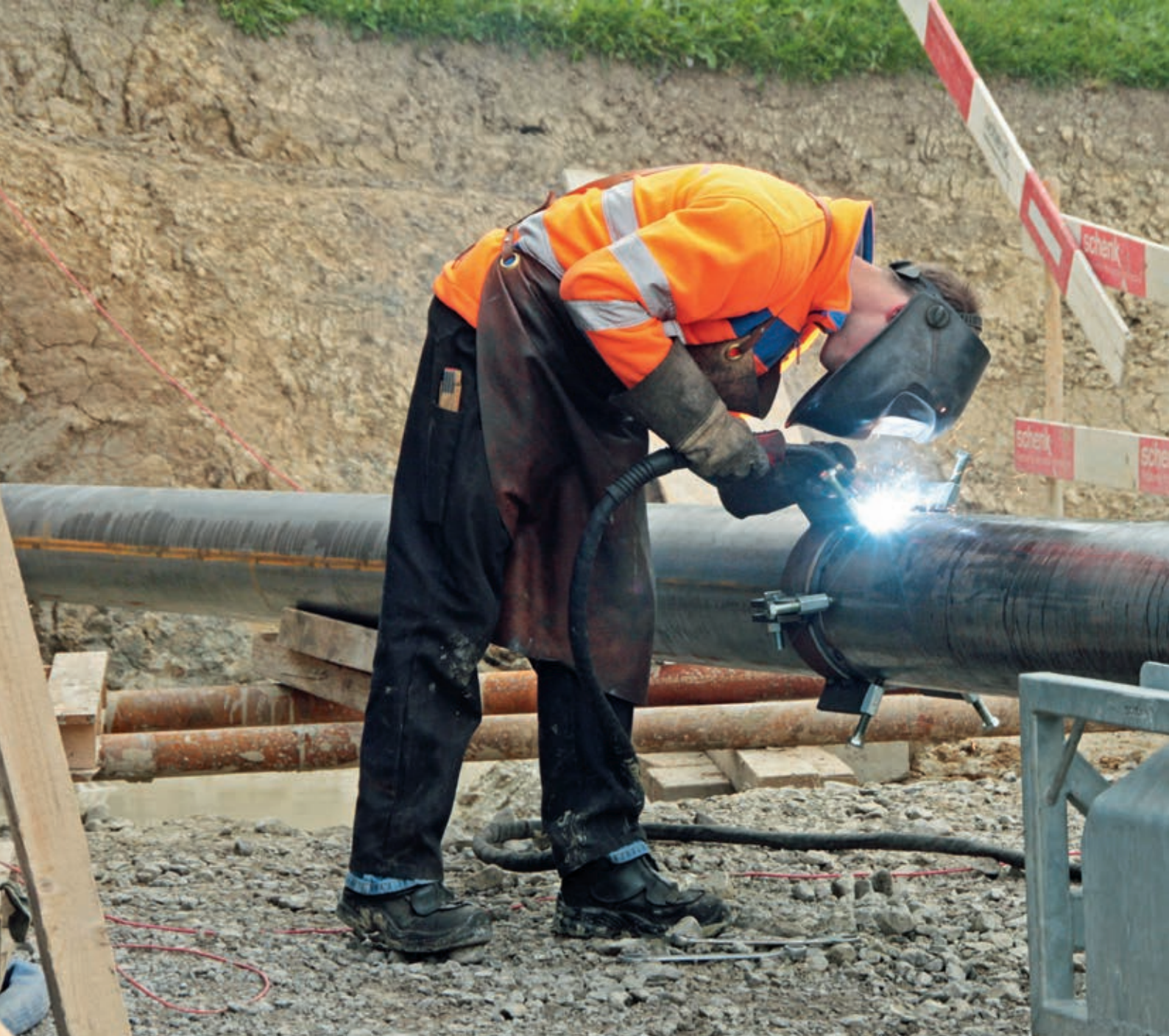
Mantelrohrschweissung und Rohreinzug von der Lobenschwendli in Richtung ARA Rehetobel
