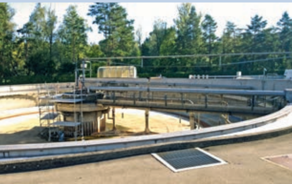
Rollgerüst und installierte Metall-Abdeckung
