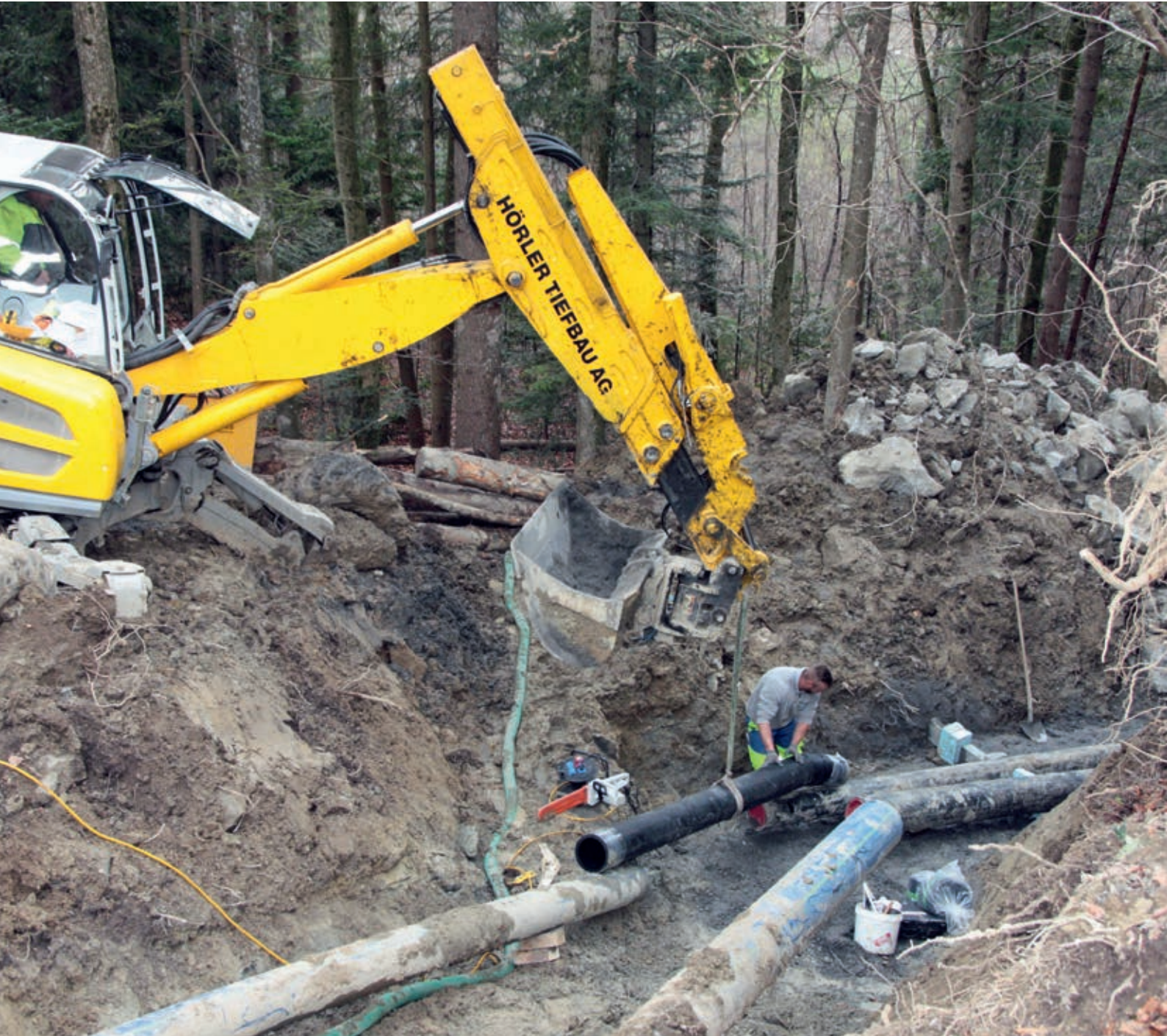
Konventioneller Graben- und Rohrleitungsbau durch unwegsames Gelände im Gebiet Herdli, Rehetobel
