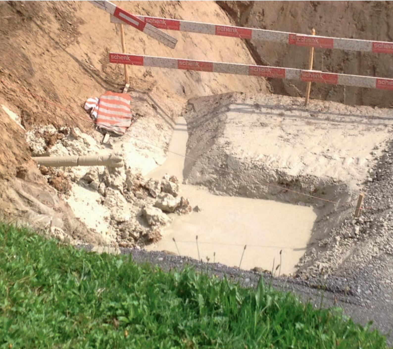
Punktlandung nach über 600 m Bohrung in der Zielgrube vom Michlenberg, Rehetobel
