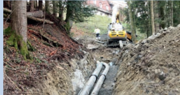
Arbeiten Anschluss Golddachtal
