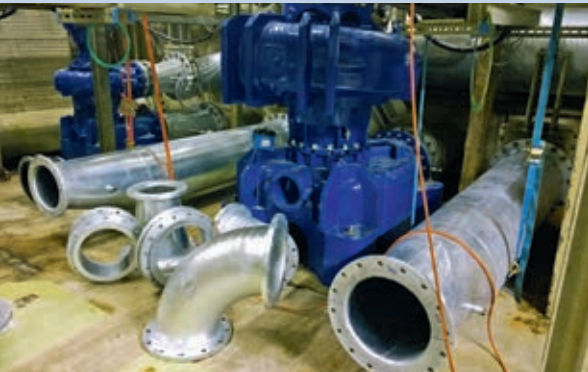
Umbau des Hauptpumpwerks: unterschiedlich dimensionierte Pumpen mit optimierter Leitungsführung
