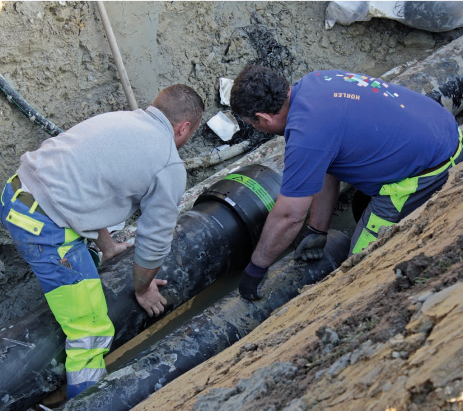
Verbindung von zwei Leitungsstücken mit einer Rohrschweissmuffe in der Lobenschwendistrasse, Rehetobel
