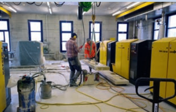
Montage der neuen Gebläse
