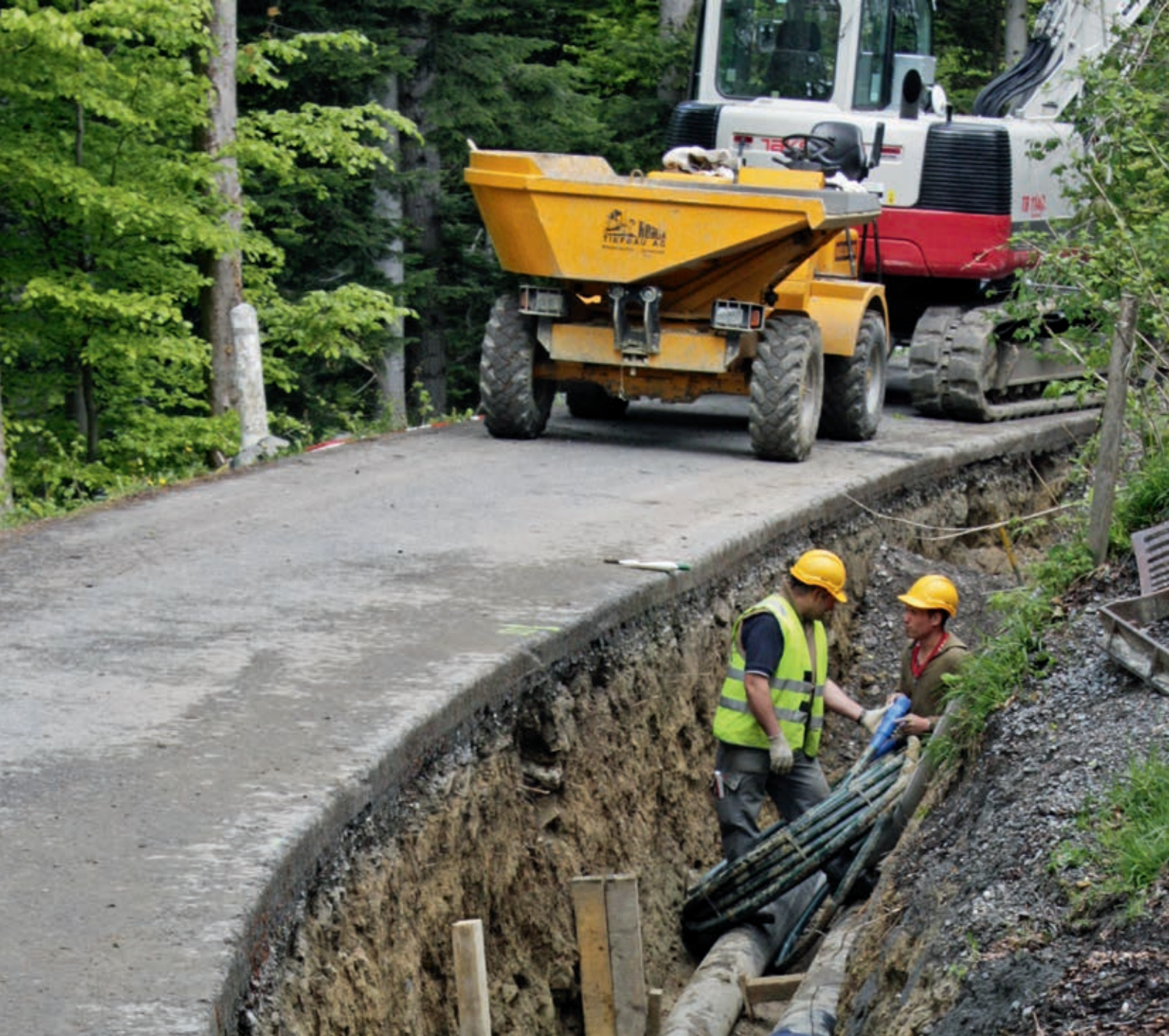
Konventioneller Graben- und Rohrleitungsbau in der Strassenfundation entlang der Lobenschwendistrasse, Rehetobel
