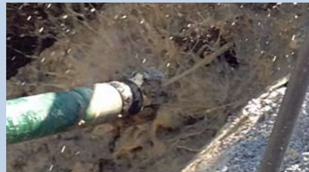
Bohrkopf in Aktion mit Bentonitspülung
