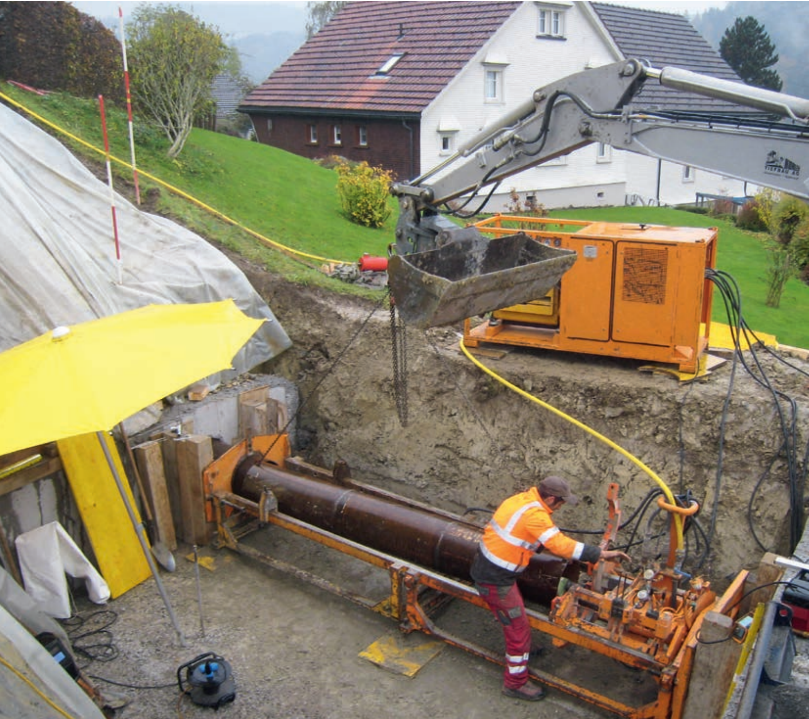
Bohrpressung unter der Kantonsstrasse im Habset, Rehetobel
