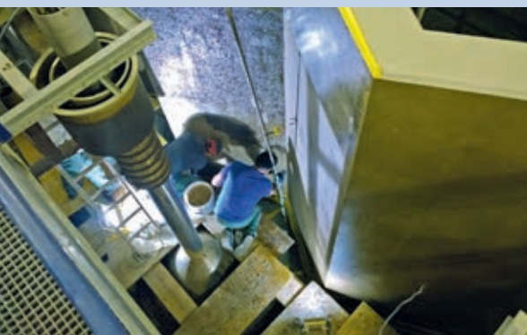
Beschichtungsarbeiten in einer Filtrationszelle
