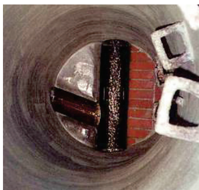
Anschluss an Einstiegschacht (Quelle: www.wernervollert.de )
