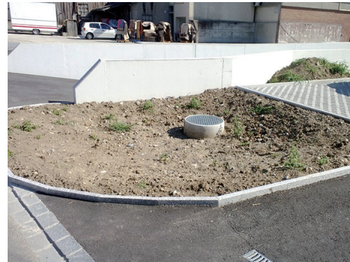
Beispiel Kombinations-Versickerung (Quelle: Amt für Umwelt TG)
