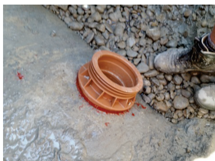
Anschluss mit Denso-Formstück (Quelle: AVA)
