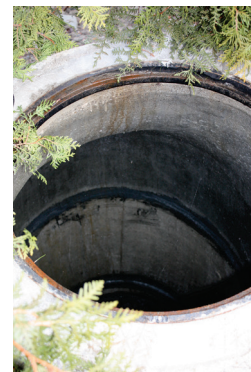
Schachterhöhung mit Konus versetzen (Quelle: AVA)
