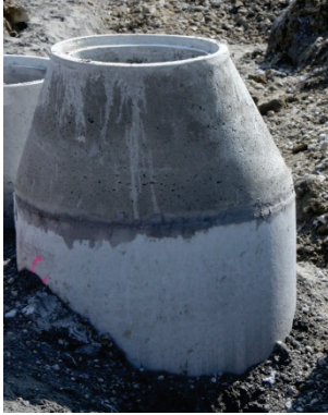
Schacht aus Betonfertigteilen (Quelle: AVA)
