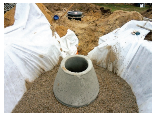
Beispiel Schachtversickerung (Quelle: www.shk-profi.de)
