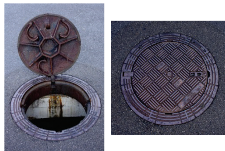
„Selflevel“-Schachtdeckel der Firma BGS (Quelle: AVA)
