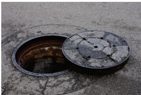
Typische Schachtabdeckung bestehend aus Schachtring und Schachtdeckel (Quelle: AVA)
