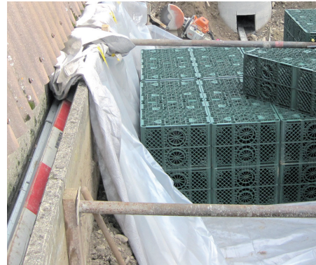
Rigole mit Sickerblock (Quelle: Amt für Umwelt TG)
