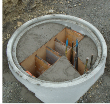
Schachtsole manuell gefertigt (Quelle: AVA)
