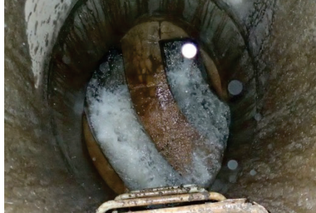
Doppelschacht – hydraulische Wechselwirkung (Quelle: AVA)
