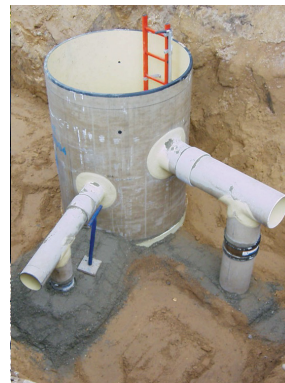
Schacht aus GFK (Quelle: www.groetz.de )
