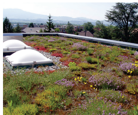
Flachdach extensiv begrünt (Quelle: www.wickidach.ch )
