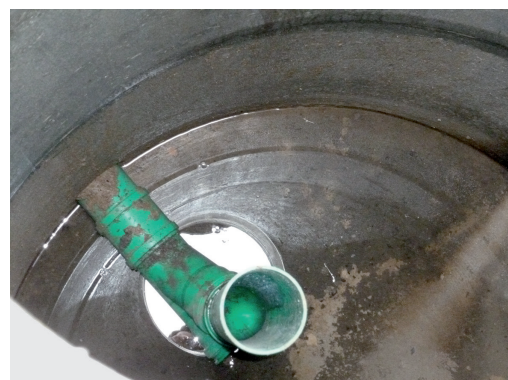
Abflussdrossel mit Notüberlauf (Quelle: Amt für Umwelt TG)
