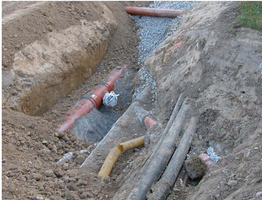
Bild 20: Hausanschlussleitung mit Anschluss an Hauptleitung im offenen Grabenbereich
