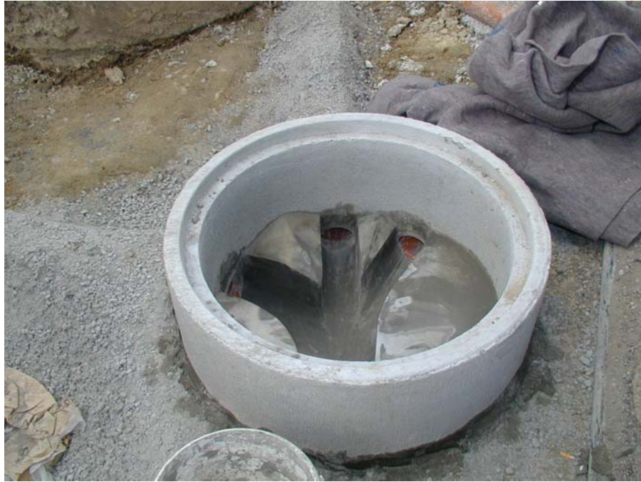
Bild 5 Konventioneller Schacht (Beton)
