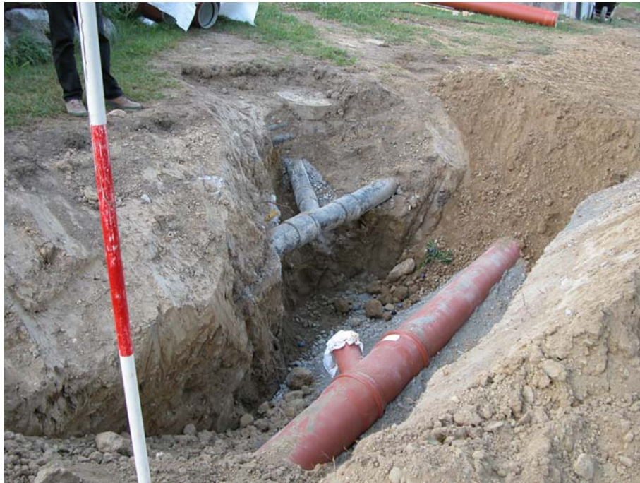
Bild 14: Konventioneller offener Leitungsgraben
