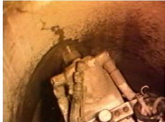
Bild 11: Kanalroboter (Sanierung Riss) (Fotos SBU)
