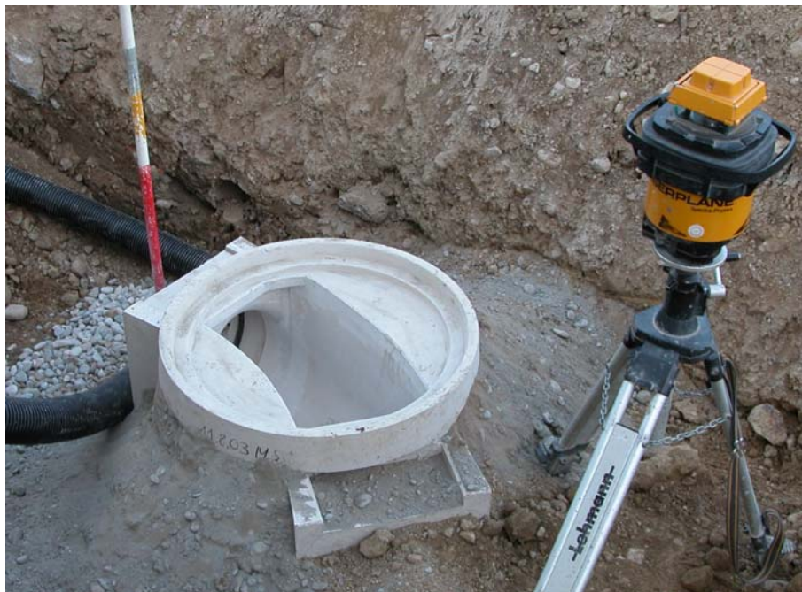
Bild 6 Fertigschacht aus Kunststoff
