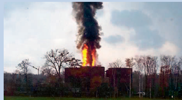
Ansicht von der Zufahrtstrasse kurz nach Brandausbruch
