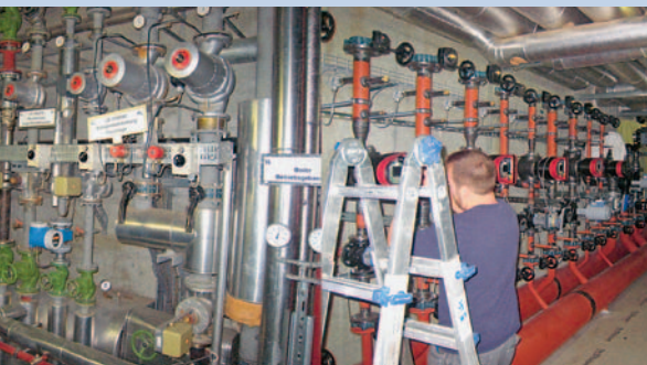
Alter Heizbalken und neue Wärmwasserverteilung in Bau
