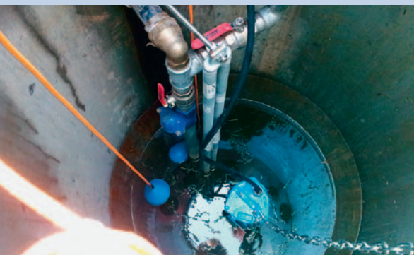
Umbau Pumpwerk Spitzli 313 – Eggersriet
