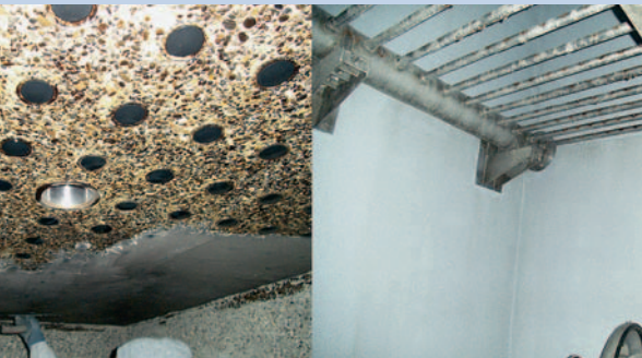
Blick auf Sanierungsarbeiten und die fertige Beschichtung
