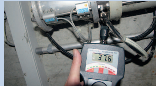
Akkustische Lecksuche bei Druckluftverbrauchern
