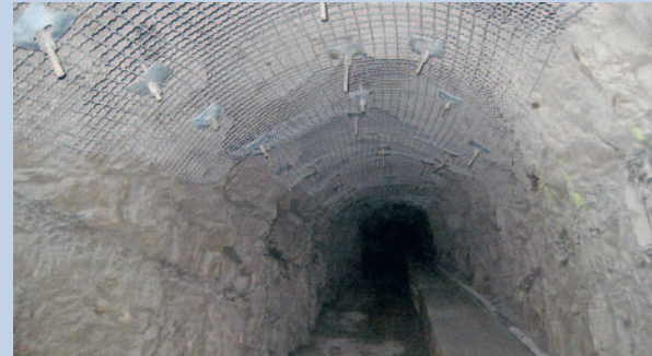
Querstollen Buechen mit Netzverankerung als Deckensicherung
