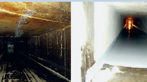
Ablaufkanal, vor Sanierung und mit Beschichtung
