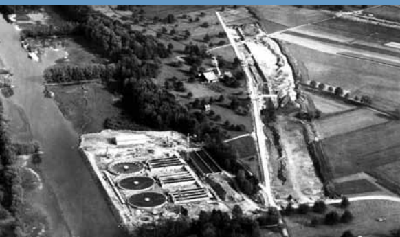
Kläranlage mit Zulaufkanal in Bau
