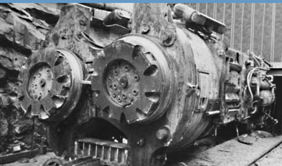
Tunnelbohrmaschine im Fuchslochstollen
