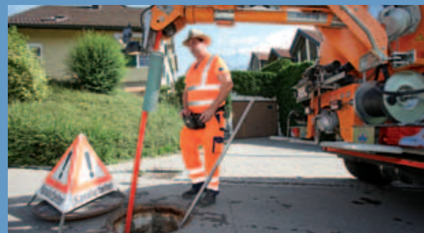
Roman Frey bei Spülarbeiten an der Kanalisation
