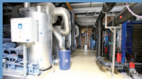
Wärmepumpenanlage zur Energiegewinnung aus gereinigtem Abwasser
