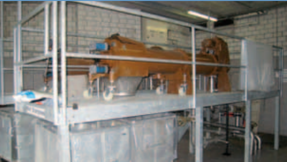
Strainpresse zur Fremdstoffentfernung aus dem Schlamm
