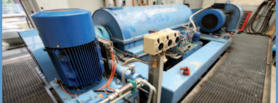
Centripresse zur Schlamm entwässerung
