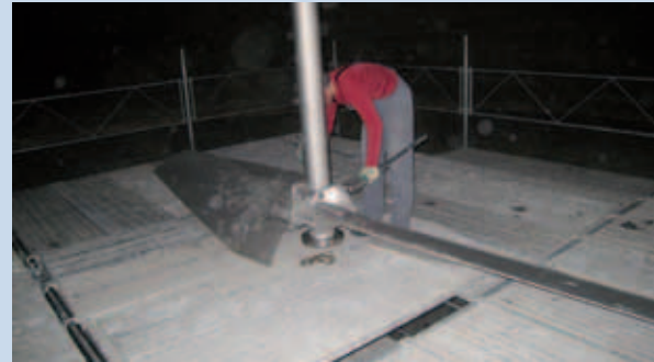
Montage des Rührwerks zur Schlamm-durchmischung in den Faulräumen
