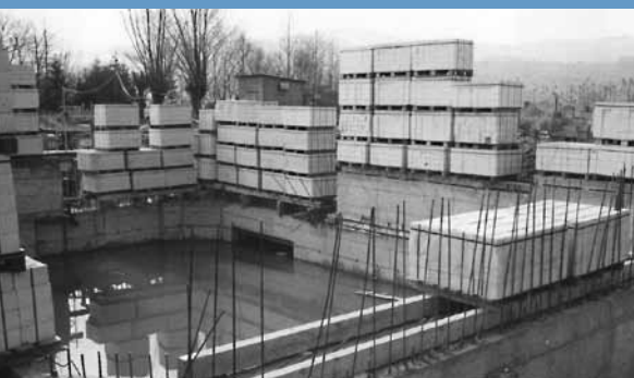
Bau Betriebsgebäude im Senkbrunnenverfahren
