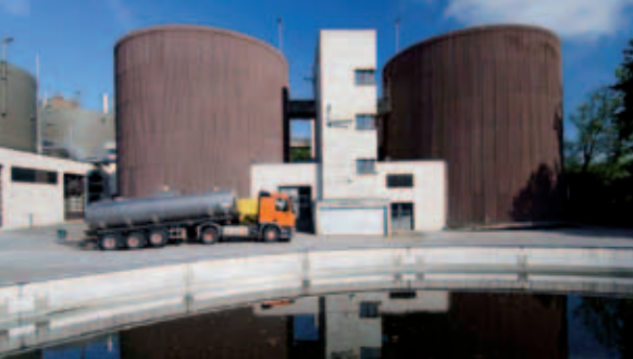
Schlammablad von Flüssigschlamm
