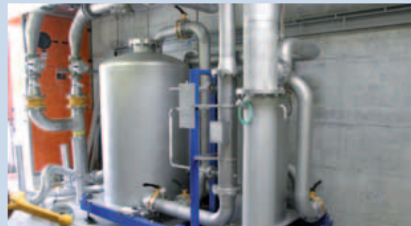
Gasreinigungsanlage zur Siloxan-entfernung
