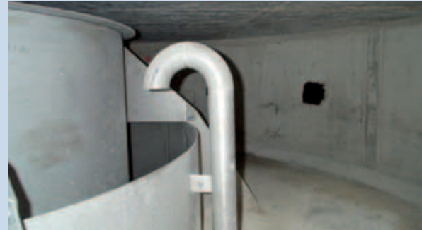
Überlauf des Wirbelabscheiders in Heiden
