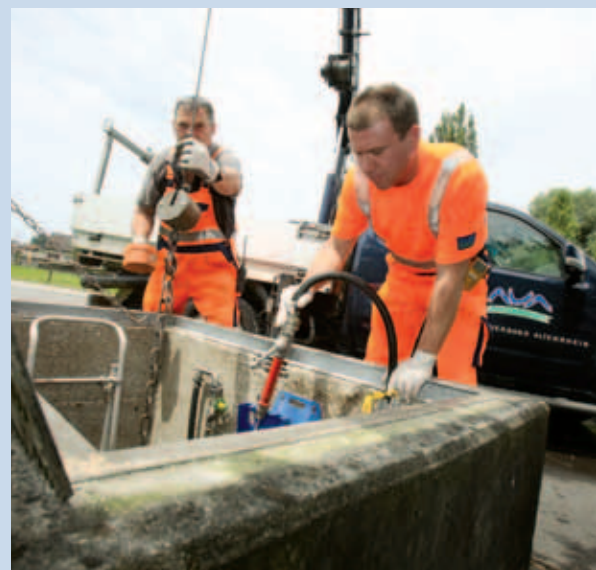
Markus Keel und Roger Keller bei Unterhaltsarbeiten an einem Pumpwerk
